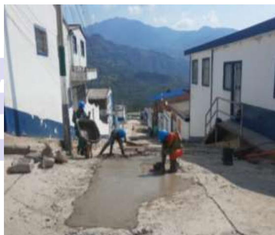
Fotografía 4: Terminación de la obra
