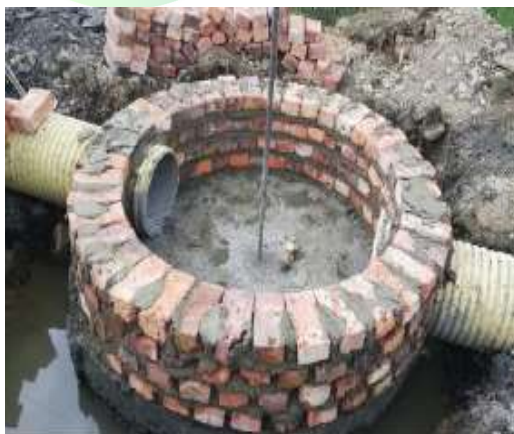
Fotografía 1: Construcción De Pozo De Inspección
