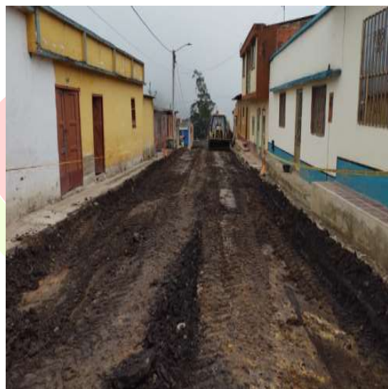
Fotografía 5: Terminación de la obra
