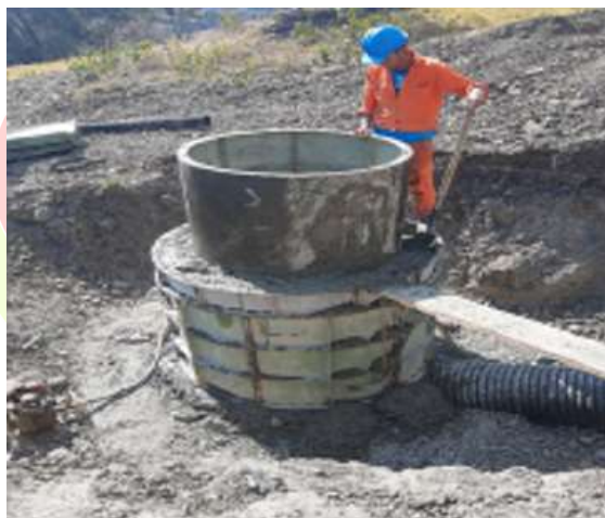
Fotografía 3: Construcción pozos de inspección
