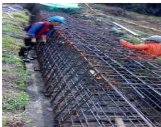
Fotografía 2: Suministro, figurado y amarre de acero
