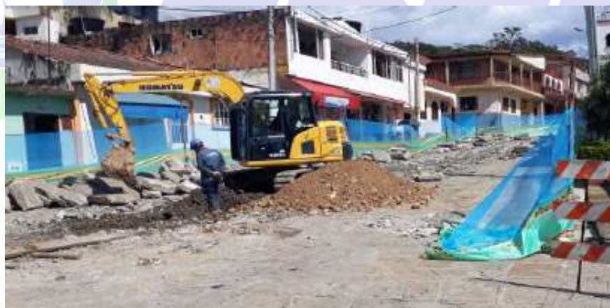
Fotografía 2: Corte y retiro de pavimento en piedra
