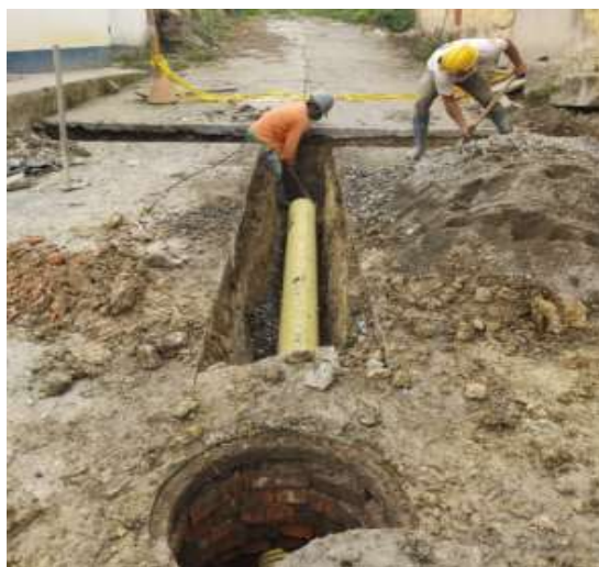
Fotografía 3: Suministro e instalación tubería
