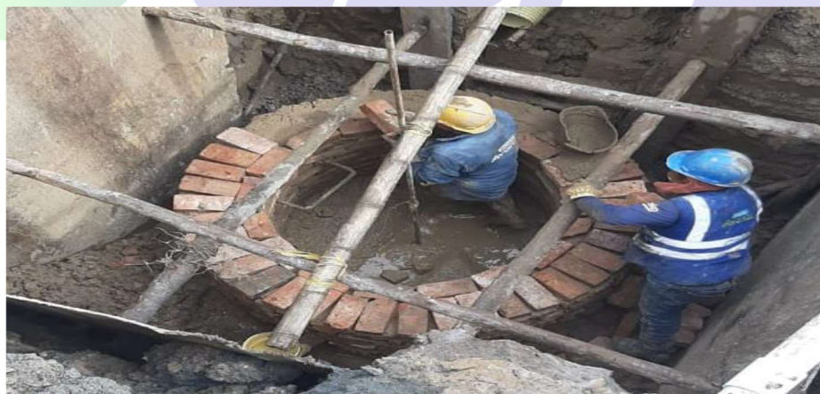
Fotografía 4: Construcción de pozos
