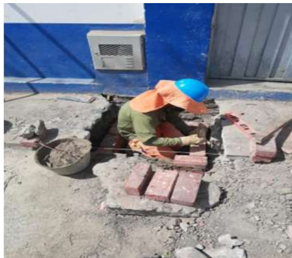
Fotografía 2: Construcción cajas domiciliarias
