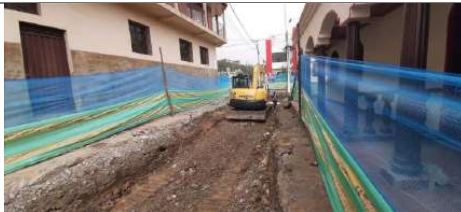
Fotografía 3: Excavación de cortes y canales
