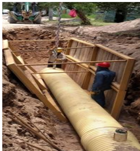
Entibado P21-P20 Calle 5
