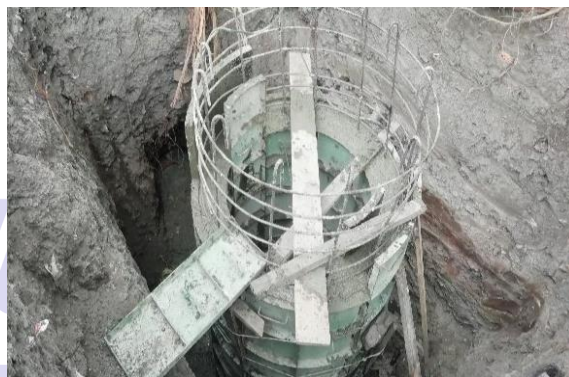
Construcción pozos inspección
