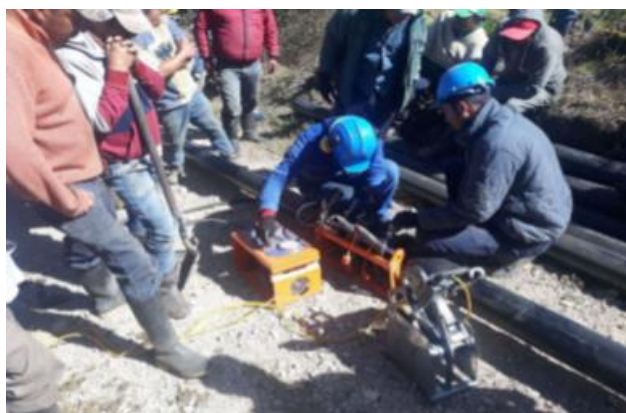
Fotografía 5 Instalación tubería Polietileno
