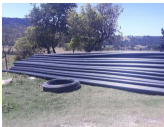
Fotografía 3 Suministro tubería Polietileno
