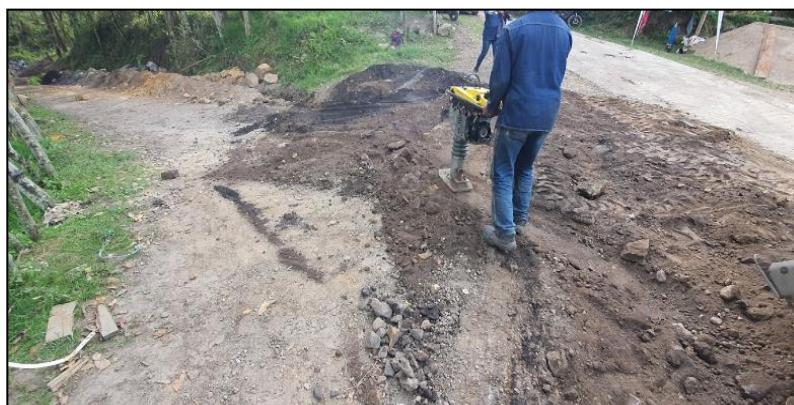
Realización de 971 m 3 de relleno con material seleccionado proveniente de excavación compactado con plancha vibradora
