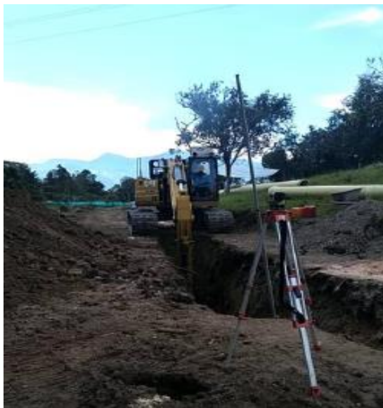
Excavación tramos para tubería
