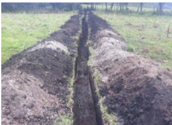
Fotografía 1 Excavación manual conglomerado
