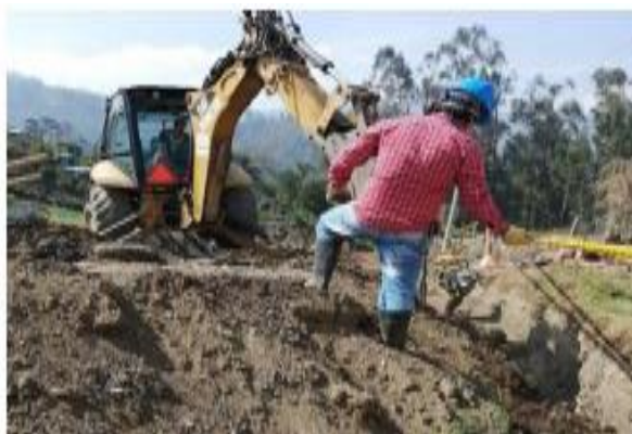
Excavación mecánica
