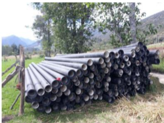
Fotografía 2 Suministro tubería Hierro Dúctil 6"
