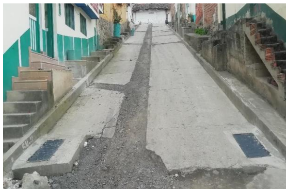
Construcción de Sumideros
