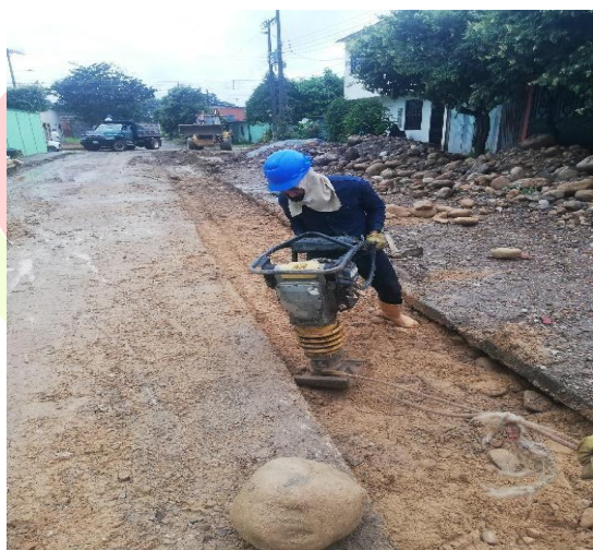
Instalación tubería 10" Calle 4
