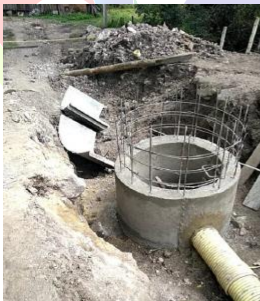
Construcción de Pozos
