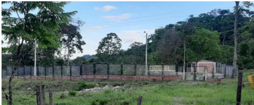
PTAR- Cerramiento Totalmente construido
