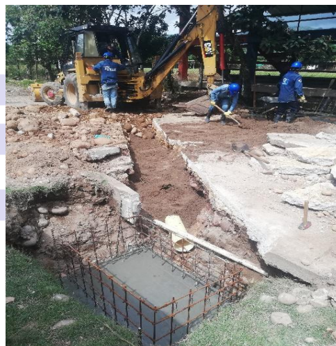
Construcción Pozo de Inspección
