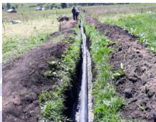
Fotografía 4 Instalación tubería HD
