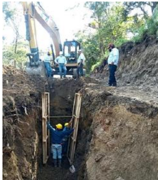
Instalación de entibados
